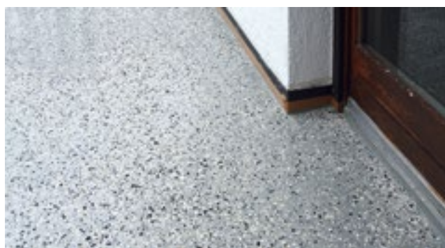
Niewielka wysokość progu drzwi tarasowych
