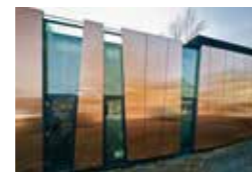
Radio-Log, Hof, D hiendl_schneis architektenpartnerschaft, Passau Franz Kraus GmbH & Co KG, Hammelburg TECU® Classic_bond
