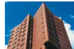
Kwatery oficerska Królewskiej Holenderskiej Marynarki Wojennej, Den Helder, NL Van Herk & de Kleijn Architecten BV, Amsterdam Ridder BV, Hoorn TECU® Classic
