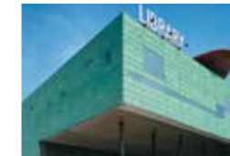
Biblioteka Peckham, Londyn, GB Alsop & Störmer, Londyn Cleveco, Enfield TECU® Patina
