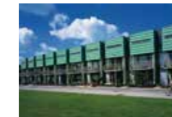
Budynek mieszkaniowy, Purmerend, NL Roy Gelders Architecten, Amsterdam Ridder Dak-en Wandsystemen BV, Hoorn TECU® Patina
