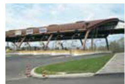
Punkt poboru opłat drogowych, Lucca, I Ettore Piras Architetto, Genuva Trenkwalder S.r.l., Ovada (AL) TECU® Oxid
